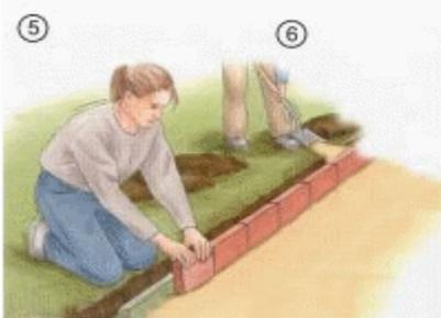
На жесткую бетонную смесь установите бордюры, в основании следует выкопать траншею и заполнить щебнем.
