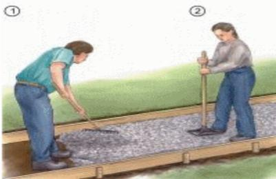
В подготовленное ложе заложите геосетку, насыпьте щебень слоем 10-20 см и разровняйте в соответствии с уклонами и уровнем. (При необходимости используйте геокаркас).
