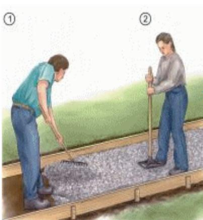
В подготовленное ложе заложите геосетку, насыпьте щебень слоем 10-20 см и разровняйте в соответствии с уклонами и уровнем.
