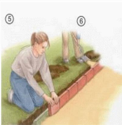
На жесткую бетонную смесь установите бордюры, в основании следует выкопать траншею и заполнить щебнем.
